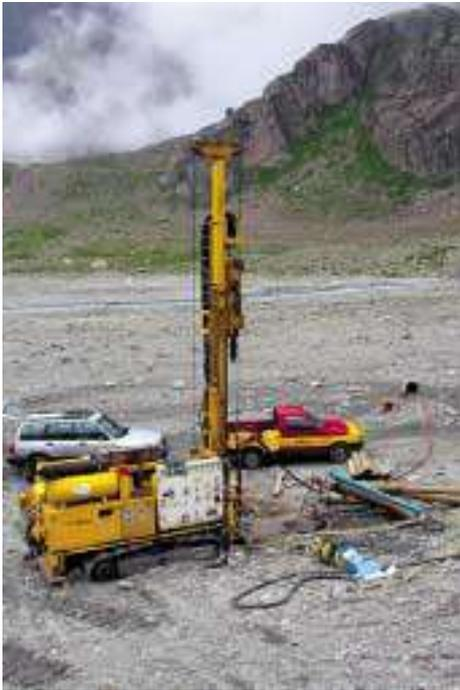
Probebohrungen zur Abklärung von Grundwasservorkommen
